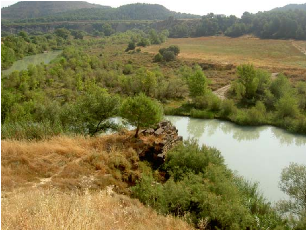
Foto del puente, antes de la remodelación
